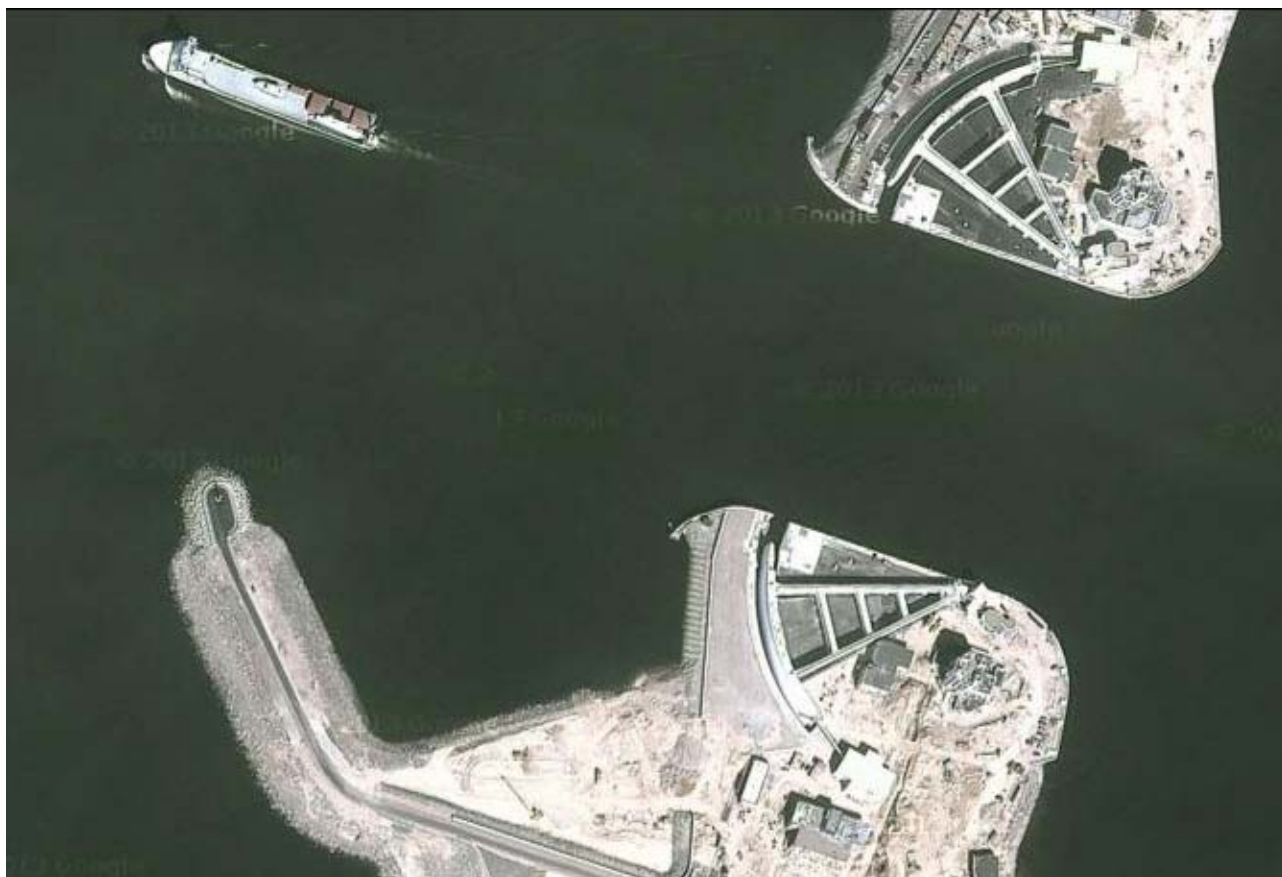
Рисунок 1 – Судопропускной канал комплекса защитных сооружений на Финском заливе
